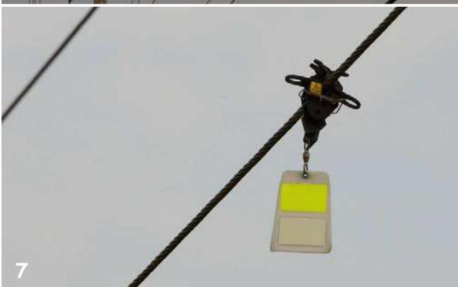
Foto 6 y 7: Aparato anticolidión colocado en línea de distribución en Seattle, EE. UU. Foto P. Valenzuela
